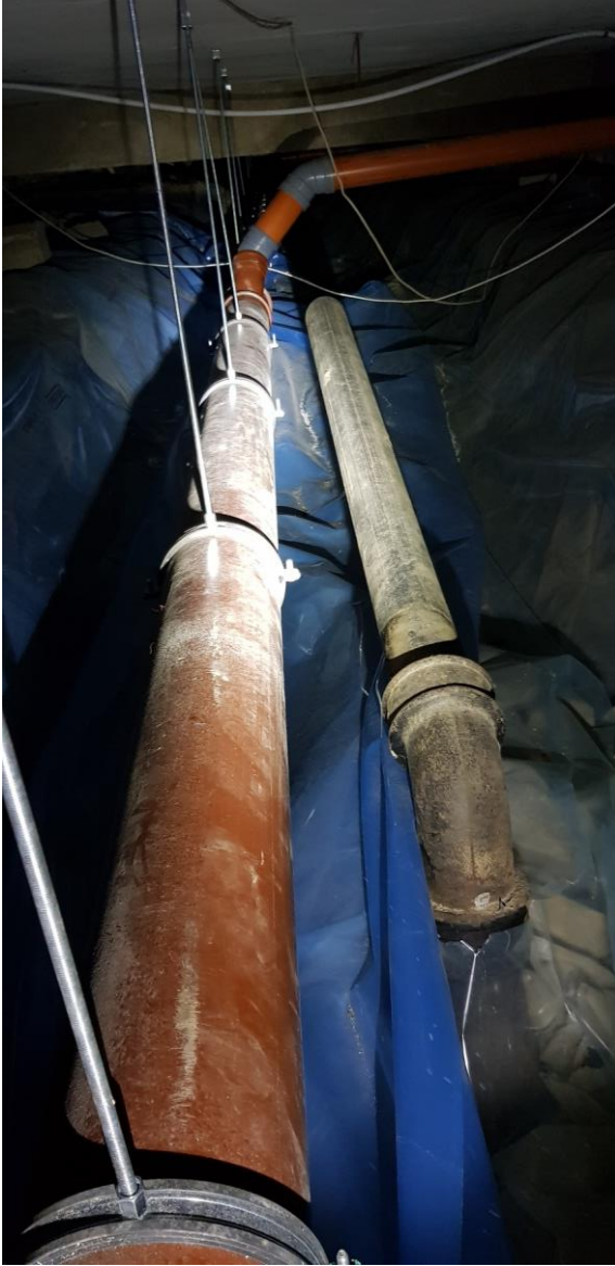
Gammelt avlopp, den högra, troe ej den är kopplad till nuvarde system
